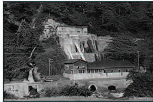
図2:真人水力発電所（昭和初期撮影）
